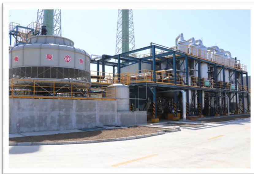
图 32 威海市海陆一体固体废物处置中心项目
