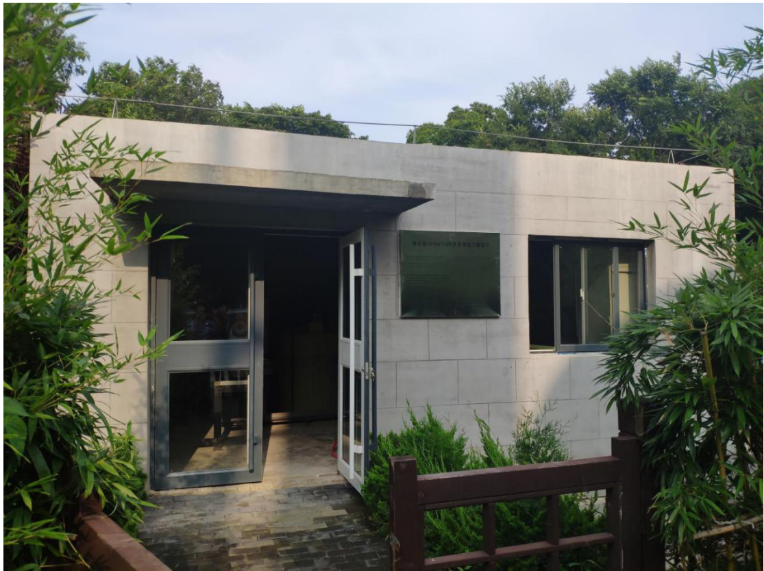
图 74 刘公岛污水处理站
