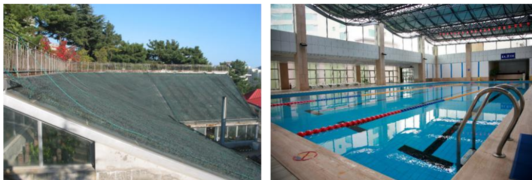
图 75 蓝天宾馆的雨水收集系统及泳池水循环管路改造
