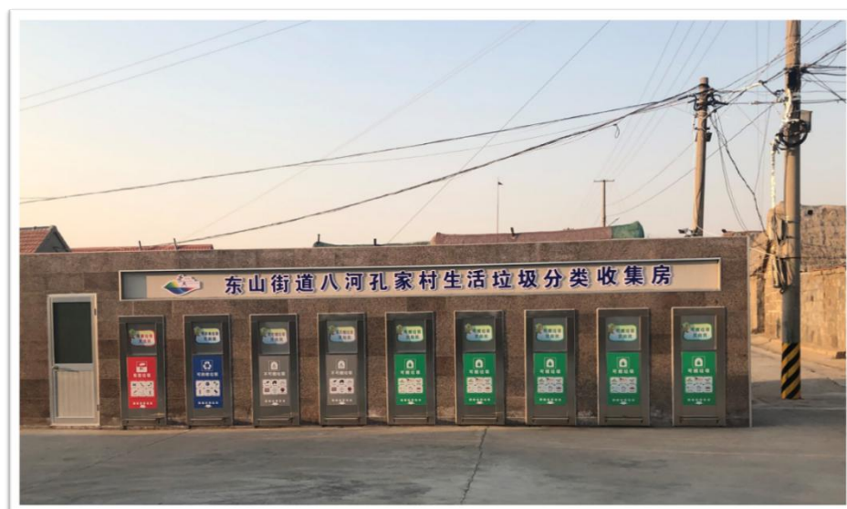
图 81 威海市农村生活垃圾分类收集房
